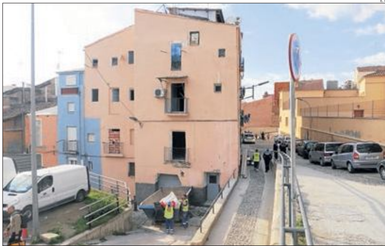
L'edifici situat a la cantonada dels carrers Gairoles i Sant Andreu va haver de ser apuntalat.
